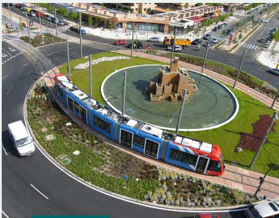
Metro Ligero Oeste.
